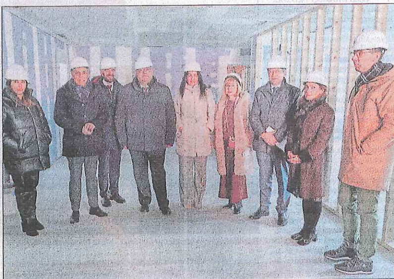
LA REFORMA DEL CENTRO DE SALUD DE PINILLA, CERCA DE FINALIZAR. El consejero de Sanidad, Alejandro Vázquez, visitó ayer el centro de salud de Pinilla en San Andrés del Rabanedo (León), cuyas obras de reforma la Junta recibirá el 30 de abril tras haber invertido 3,7 millones de euros para ampliar la superficie un 20%.
